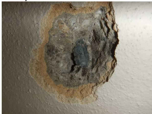
Foto č. 9 a 10 – sonda NV 4 – celkový pohled, detail výztuže
