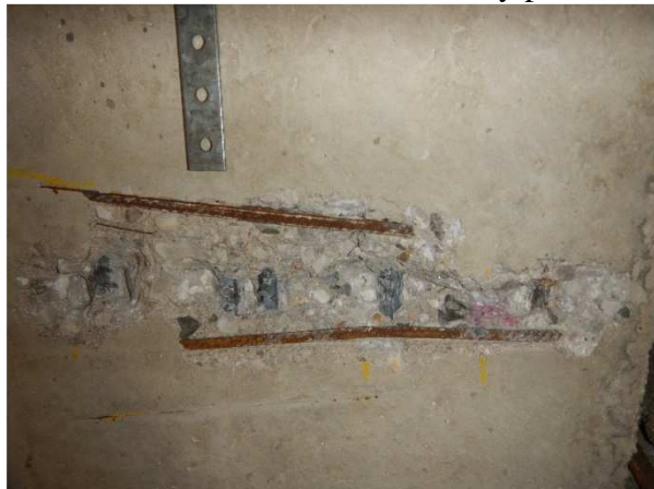
Foto č. 1–4 – sonda NV 2 – celkový pohled, detail výztuže
