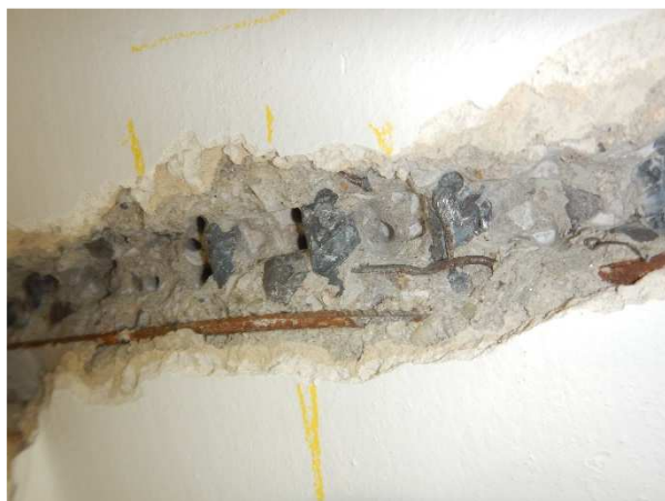
Foto č. 5–8 – sonda NV 3 – celkový pohled, detail výztuže
